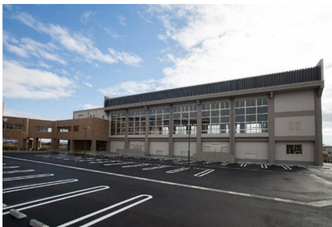
【鉄骨造（小学校体育館・プール）】
