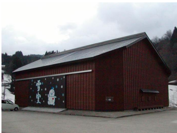
【木造建築（雪中貯蔵施設）】
