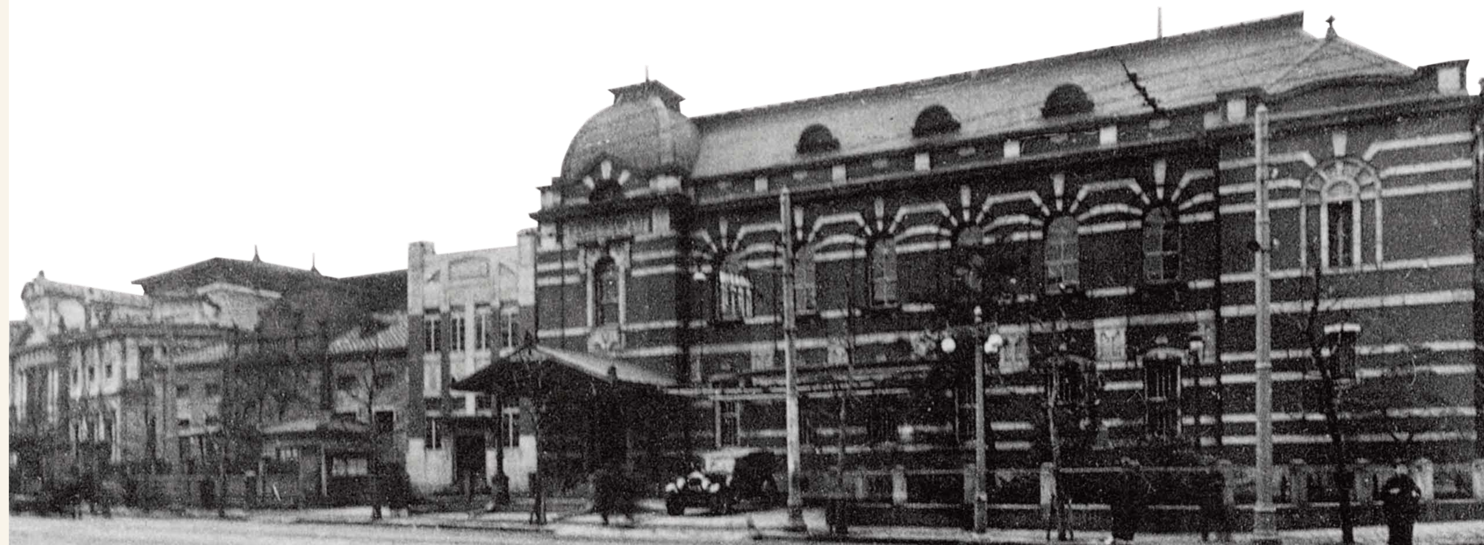
左端の複雑な屋根をもつものが明治32年建設、その右が明治27年建設。その右の縦長の建築は未詳だが、デザイン的に見て、大正期の増改築によるもの。その右側の大きな赤レンガ建築が明治44年建設のもの。
