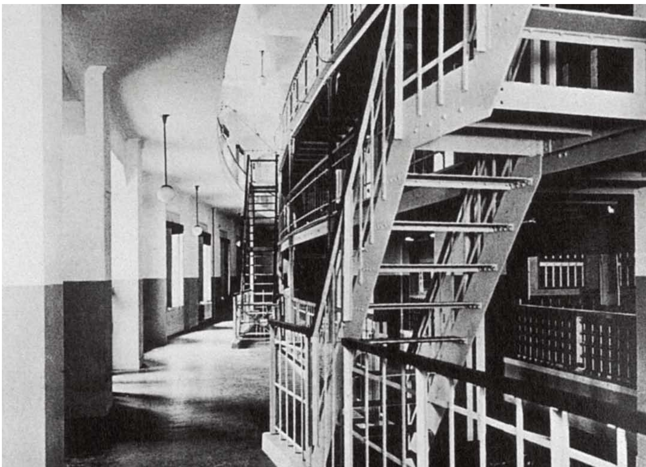
立会場3階外周に設けられた、株価表示板を操作するための通路。
