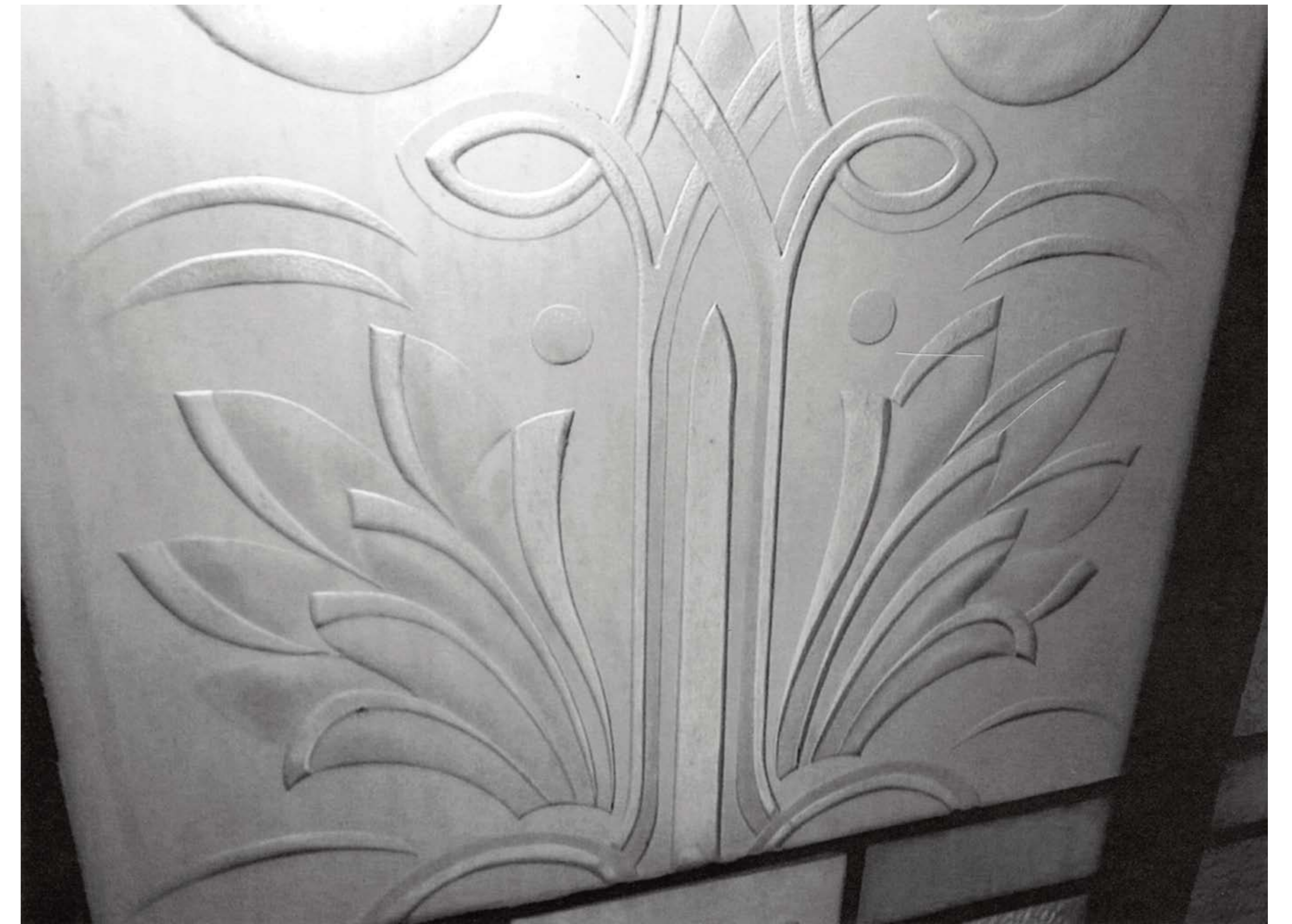
エッチングガラス詳細。厚さ5ミリのガラスを用いている。固定する鉛の溝中に合わせるため、周囲を3ミリ厚に削っている。
